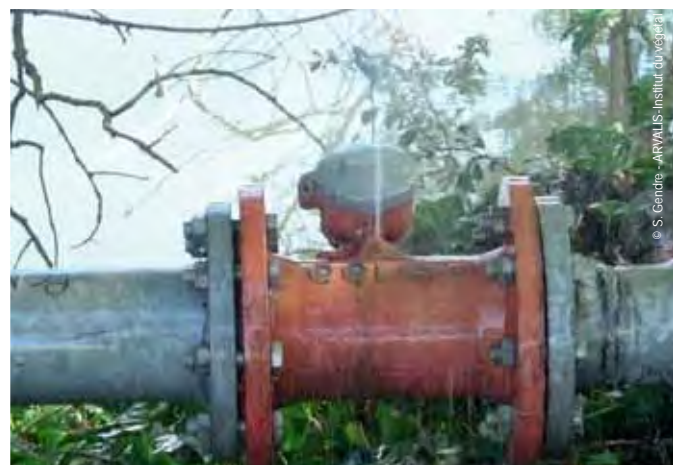
Afin d'optimiser l'irrigation, il faut éviter les fuites ainsi que les pertes par dérive dues au vent. En cas de vent fort, irriguez en dehors de la période 11 h-20 h.
