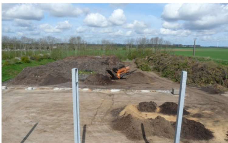
L'atelier de compostage et le futur bâtiment en construction
