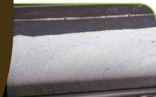
① Couche de 10 cm de substrat inerte, ici perlite
