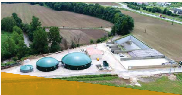
FIGURE 36. Unité de méthanisation. Source : Solagro.
