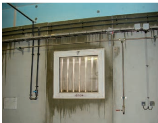
Exemple de ponts thermiques sur la zone de chaînage
