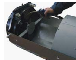
Soufflage d'un aérotherme
