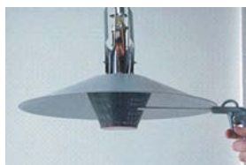
Soufflage d'un radiant
