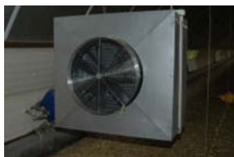
Un aérotherme eau chaude
